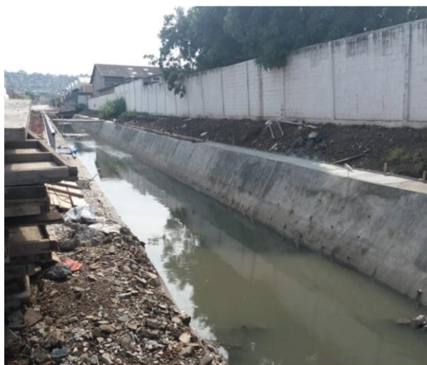
Canal de la Av. Juan Tanca Marengo
